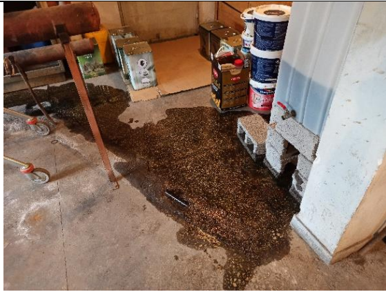
1. Ζημιά στη δεξαμενή αποθήκευσης
